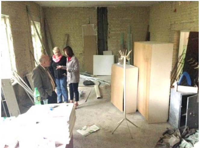
Der größte Raum in der Miniwerkstatt
