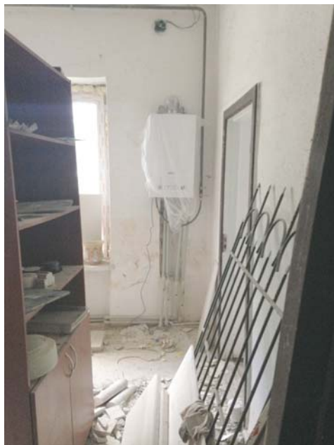
Die neu installierte Gasheizung in der Miniwerkstatt
