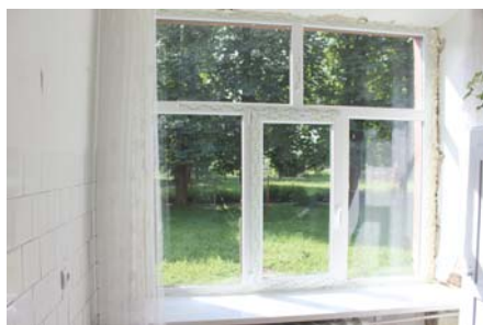
Neues Fenster im Kindergarten 34
